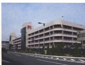
羽田空港立体駐車場(新築)
