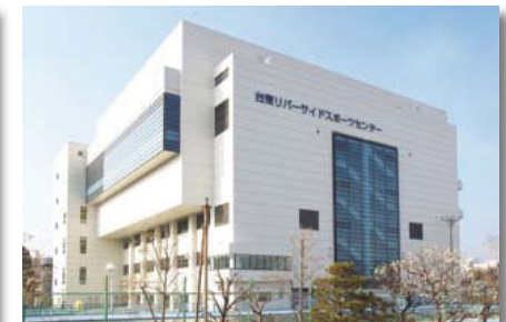
台東リバーサイドスポーツセンター (サーモシャット工法)
