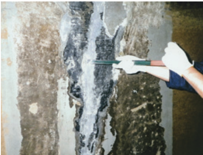
コンクリート裂化部除去
