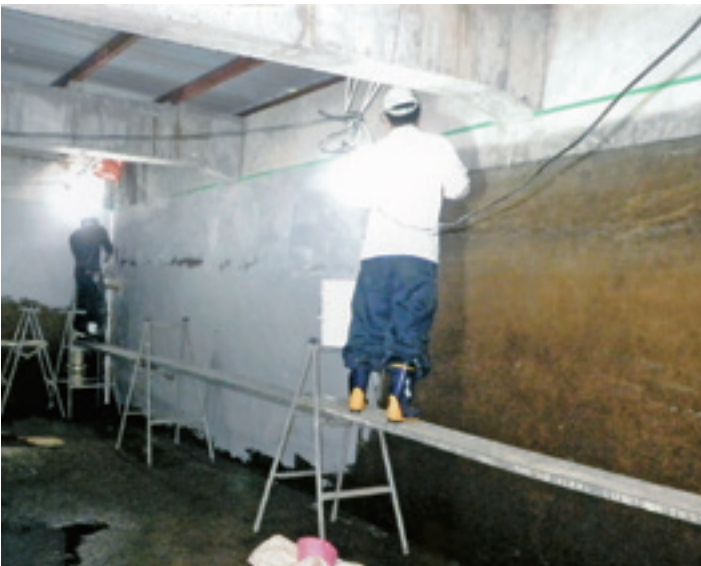
地下水槽コンクリート保護補強
