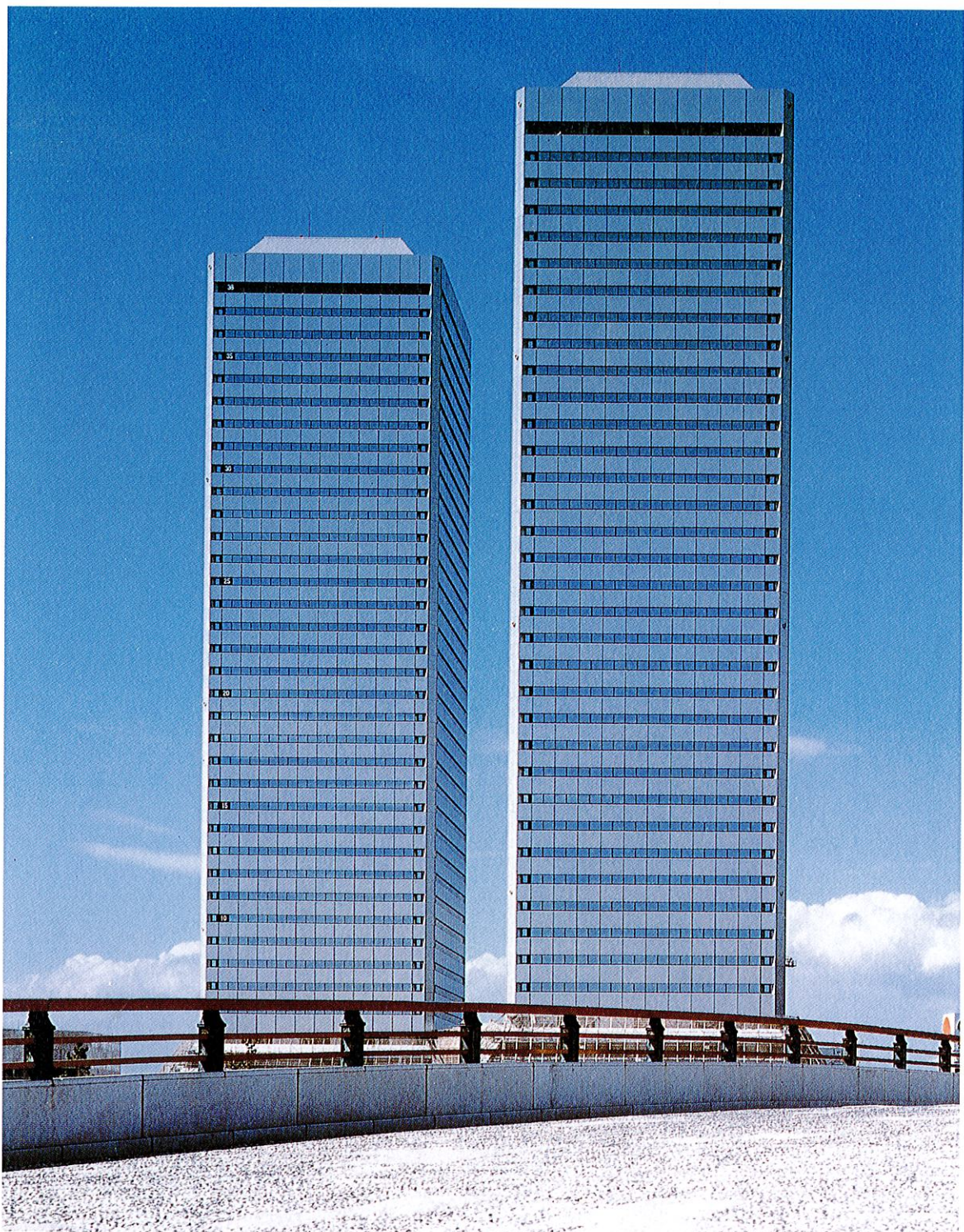
大阪市 ツインビル21 使用材料( IP 特殊シーラー・ IP テープコート強力型・ IP パテ万能内部用・ IP パテ青缶)
