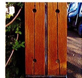
水洗→リグノブライト1回塗り →ノンロット2回塗り
