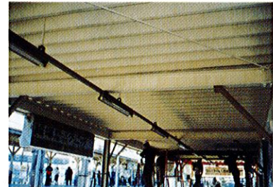
はけ塗り ローラー塗り 西武鉄道 武蔵藤沢駅 折板屋根裏
