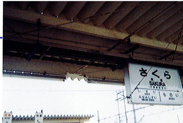
88,12, 塗装完了 JR 佐倉駅折板屋根裏
