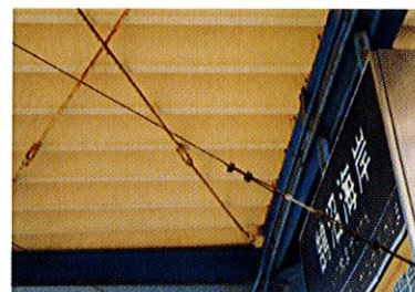
塗装後、15年経過 小田急電鉄 鶴沼海岸駅 折板屋根裏
