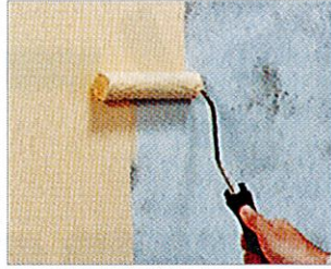
エコ美ウォールをウールローラーで塗布。 (2回または3回塗り) ※2回・3回目は指触乾燥後
