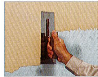
パレットHG、けいそうファームコート、 サーブルコートなどの上塗材を塗布。 ※下地の状況により、上塗材塗布前に SKカチオンプラスター弾性タイプ で下地処理をしてください。
