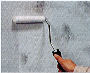
カビ止めシーラーをウールローラーで塗布。
