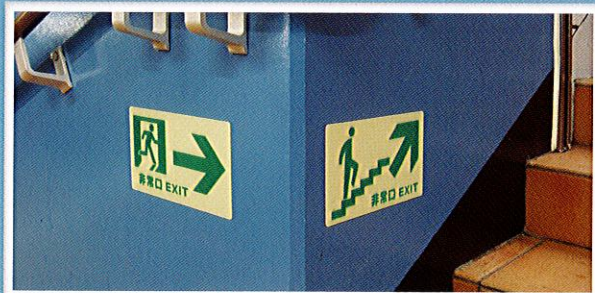
通路へ避難誘導[蓄光]シール設置
