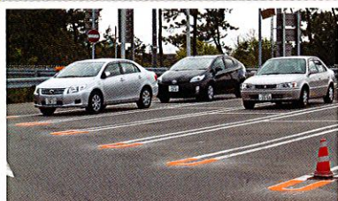
駐車場区画ライン
