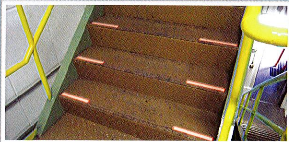
階段へ[蓄光蛍光]シール設置
