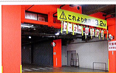
地下駐車場 危険箇所(柱)
