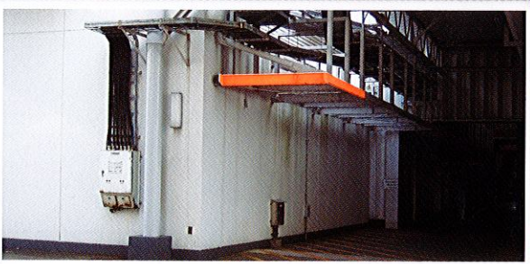
衝突防止箇所へ[蛍光]塗装
