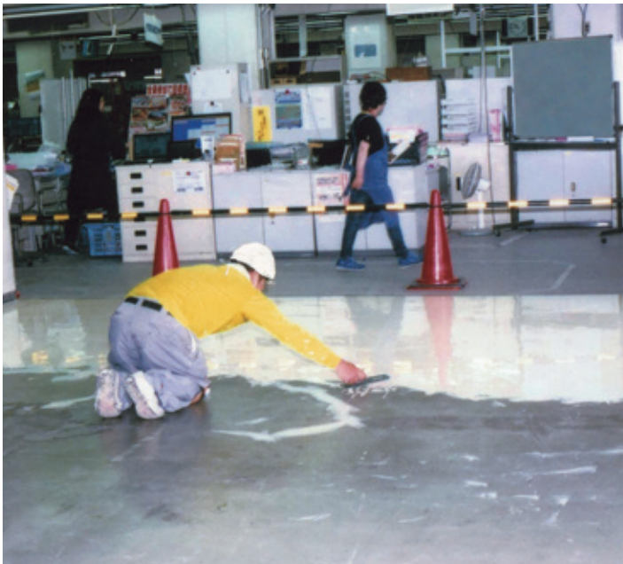
オフィスビル床改修
