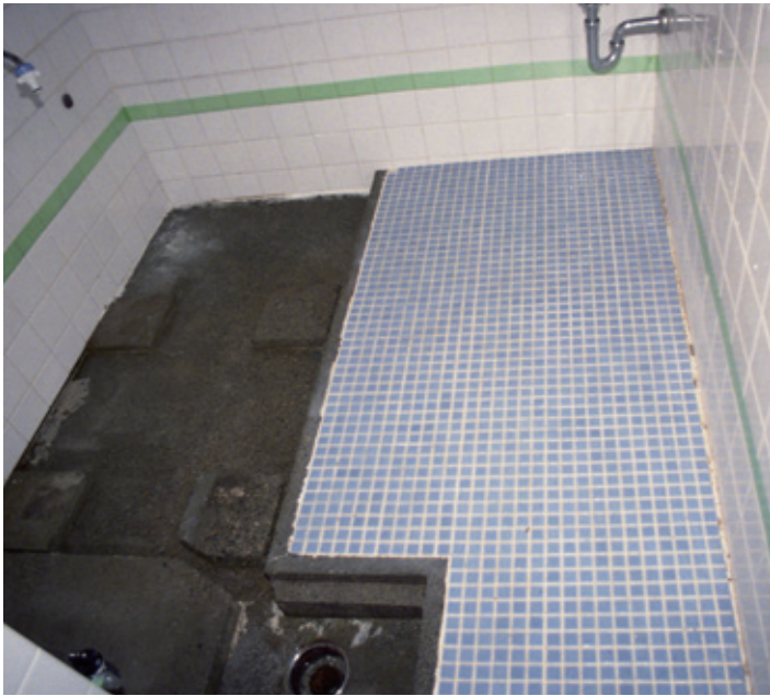
タイル浴室床3%塩酸使用洗浄清掃
