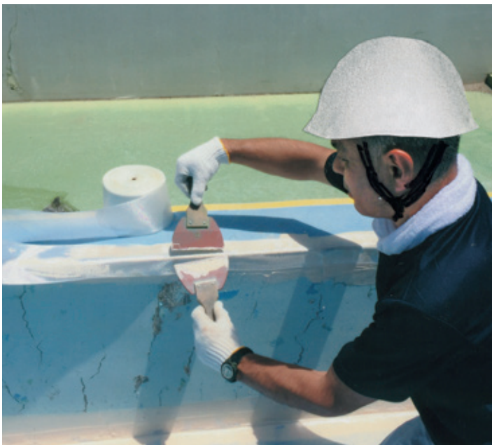
FRP樹脂プール補修 ガラスクロス補強
