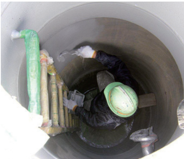
マンホールライニング（洗浄清掃）
