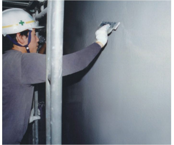
リシンガン使用塗布後、コテ類使用均し作業
